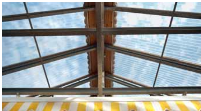
Transparente Stegplatten sorgen für den positiven Treibhauseffekt.
