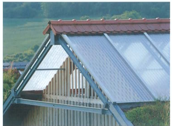
5 Die natürliche Zirkulation der Luftschicht zwischen Außen- und Innenhaus sorgt dafür, dass die Wasserdämpfe abgeleitet werden.
