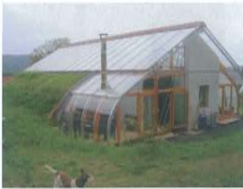
3 Das Außenhaus bietet vor allem Wetter-schutz. Es besteht aus einer wärmedämmenden Schicht und zu einem Großteil aus Glas.
