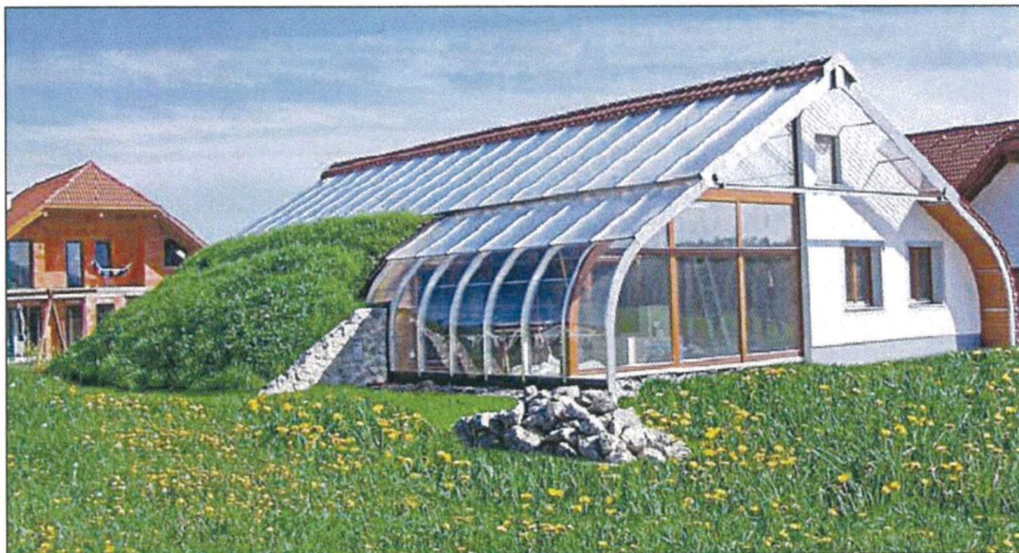
Haus-im-Haus-Prinzip: Auftraggeberinnen und Auftraggeber können in ihrem neuen Bio-Solar-Haus komplett auf aufwendige Dampfsperren und kostenintensive Lüftungstechnik verzichten. Foto: djd/Bio-Solar-Haus GmbH
