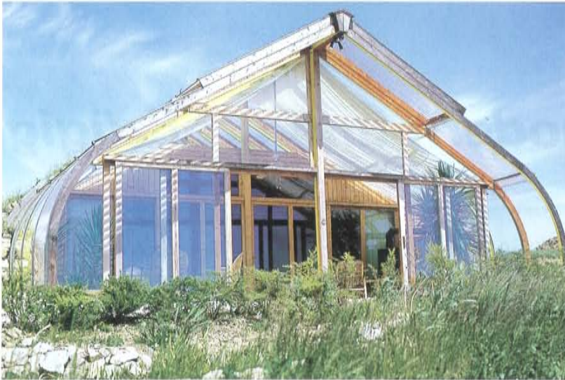
Das bis auf den Boden reichende Dach ermöglicht eine problemlose Entwässerung der Begrünung.
