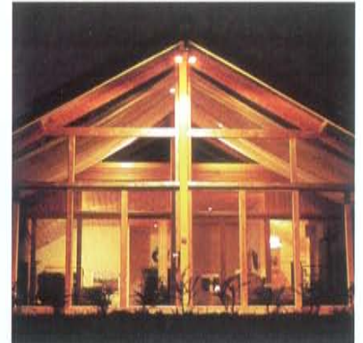
Wärmegewinnung durch großflächige Verglasung. Ill.: Bio Solar
