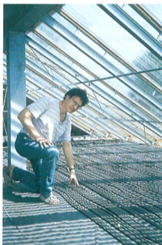
900 Meter Gummischlauch unterm Glasdach dienen als Kollektor
