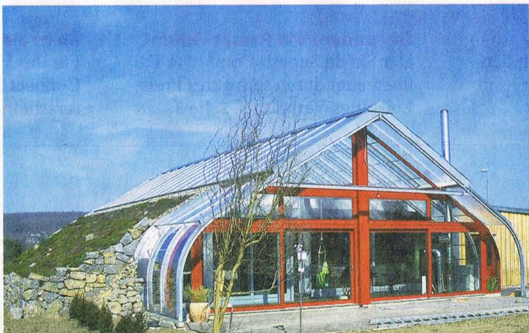
Doppelte Hülle: Das Außenhaus bietet vor allem Wetterschutz
