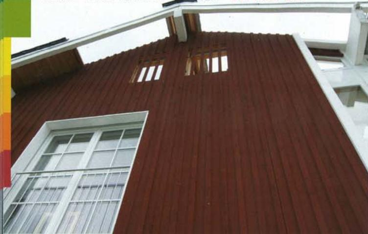
**LUFTSCHLITZE:** Die Öffnungen am Giebel ermöglichen den Luftaustausch.
