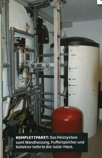
**KOMPLETTPAKET:** Das Heizsystem samt Wandheizung, Pufferspeicher und Kollektor lieferte Bio-Solar-Haus.
