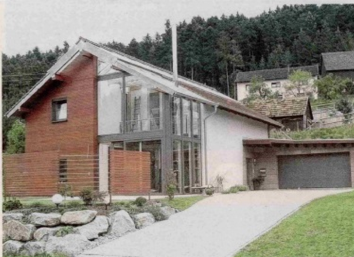
Innovativ: Die Luftschicht zwischen Wetterschutzhaus und Innenhaushülle hält das Innenhaus im Sommer angenehm kühl und wärmt es im Winter wie ein Mantel. FOTO: DIDIBIO-SOLAR-HAUS
