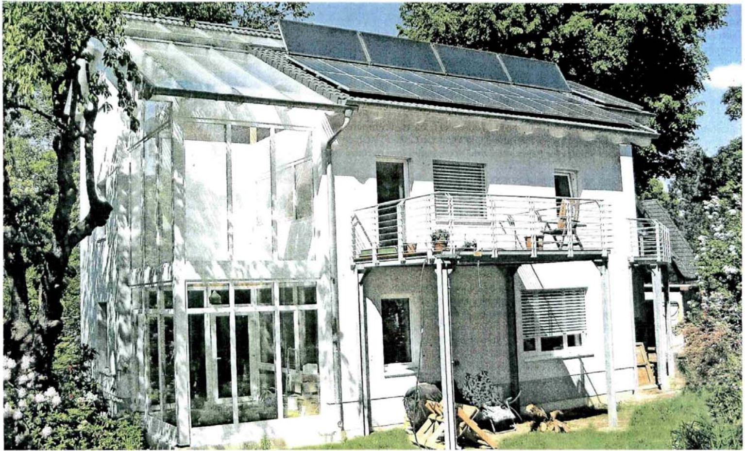
-Der Bauherr kann bei seinem neuen Bio-Solar-Haus komplett auf aufwendige Dampfsperren und kostenintensive Lüftungstechnik verzichten. FOTO: DJD/BIO-SOLAR-HAUS GMBH
