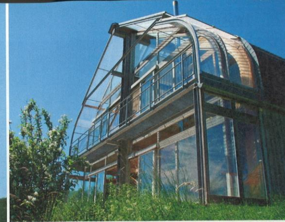
Typisches Merkmal eines Bio-Solar-Hauses ist die teilweise transparente Außenhülle, die die solaren Gewinne optimiert und vor Witterung schützt.
